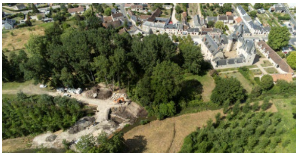
Le site du chantier et le château de Fougères-sur-Bièvre © C. Ananiguan - CMN
