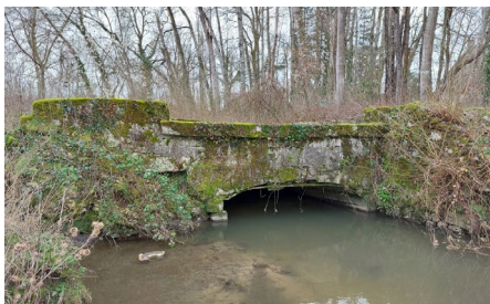
Le pont-canal avant les travaux
